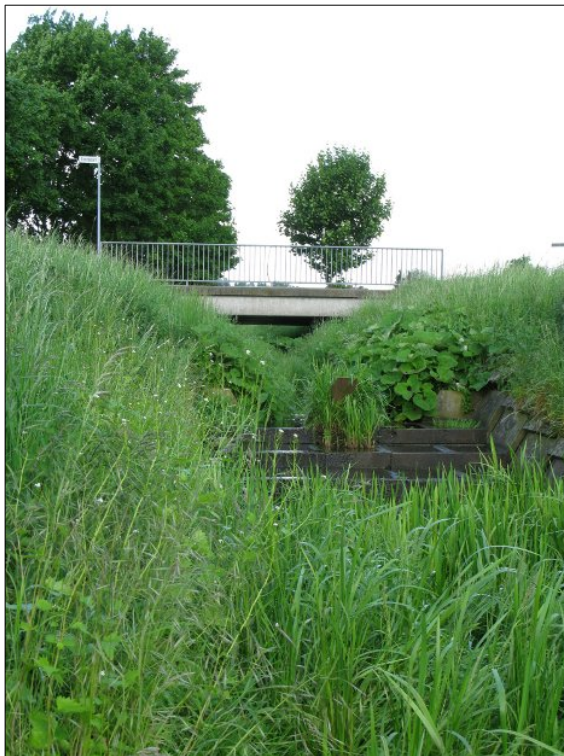
Brücke über dem Tiberbach an der Kreuzung Gausepatt und Hülstener Straße
