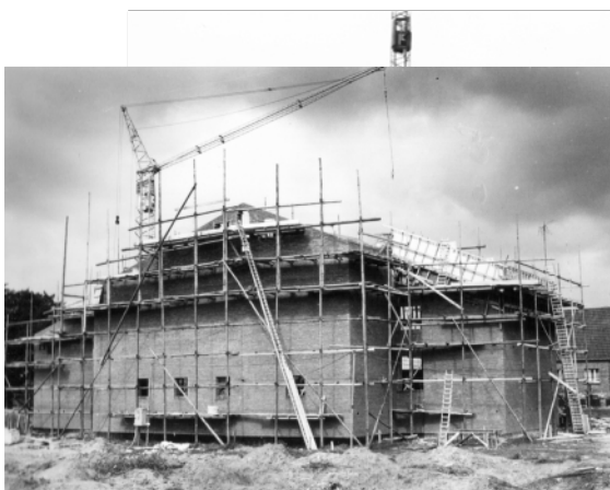
Südöstliche Ansicht des Rohbaus im August 1962
