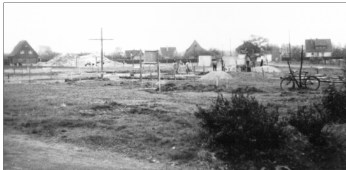
Bauplatz der Josephskirche an der Josef-Heiming-Straße
